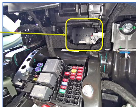
Возможное место расположения блока – над блоком предохранителей слева от рулевой колонки.
